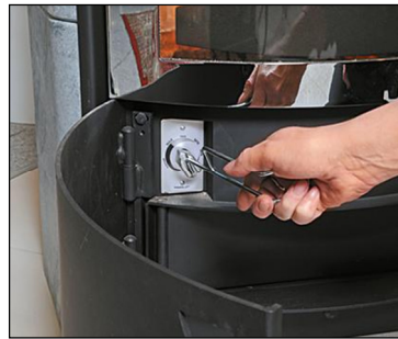
Slika 10; Toplotno moč se določi s količino dodanih polen, le izjemoma z regulacijo zraka (Vir: www.heimwerkerlexikon.selbermachen.de )
