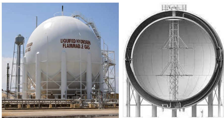
Slika 15. Obsežni sferični rezervoarji za shranjevanje tekočega vodika, ki jih uporablja NASA. 2
