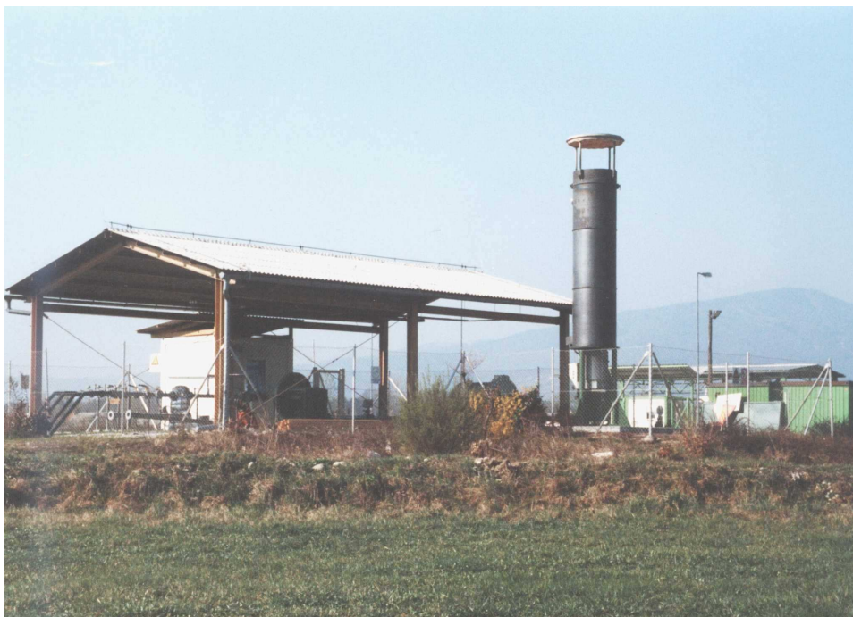
Slika 4: Plinska postaja z baklo za sežig odlagališčnega plina (Vir: Snaga d.o.o.)
