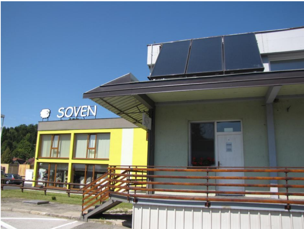
Slika 1: Primer podjetja z vgrajenimi sončnimi sprejemniki za pripravo tehnološke vode v proizvodnih procesih.
